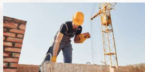
THI CÔNG XÂY TÔ
