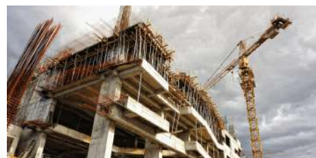
THI CÔNG KHUNG NHÀ
