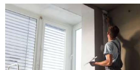
THI CÔNG SƠN
