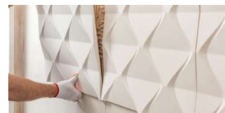
THI CÔNG NỘI THẤT
