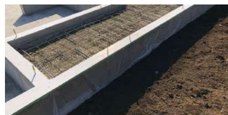
THI CÔNG MÓNG
