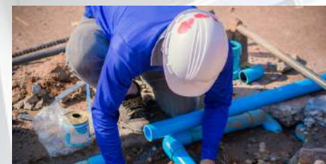
LẮP ĐẶT HỆ THỐNG M&E
